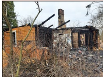
Pożar domu w Starym Gaju. Budynek praktycznie doszczętnie zniszczony.
