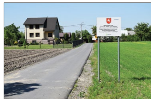
Droga w miejscowości Płowizny
