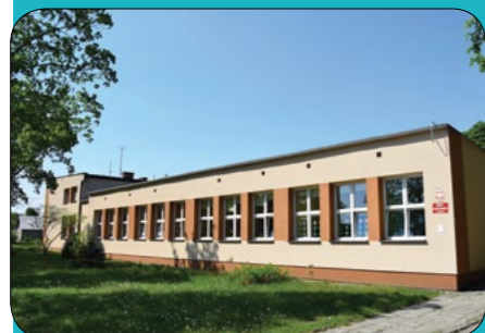
Budynek Szkoły Podstawowej we Wronowie - gmina Bełżyce przekazała na remont 87 988,47zł.
