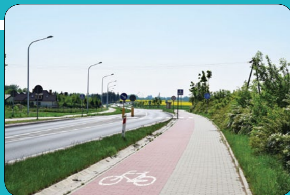
Odcinek drogi 747 w miejscowości Matczyn
