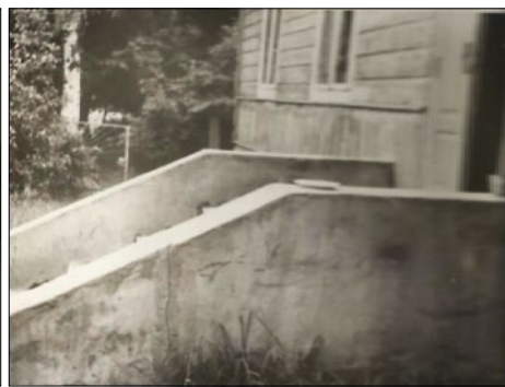
Fragment schodów przy wejściu do budynku
