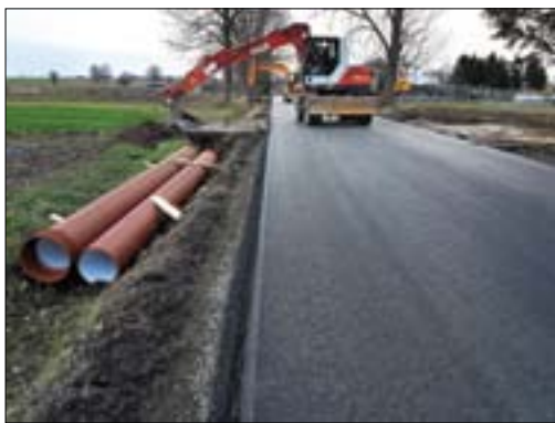
Tak wyglądały prace na drodze w Wierzchowiskach
