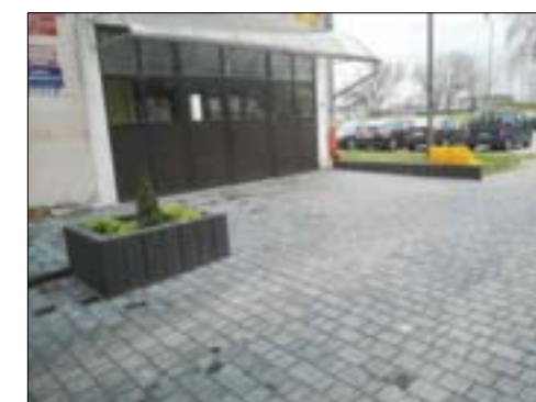
Przebudowa budynku przy ul. Fabrycznej. Wartość zadania to 32,3 tys. zł. w tym dofinansowanie ze Starostwa Powiatowego w Lublinie 21,6 tys. zł. Powierzchnia 200 m2.
