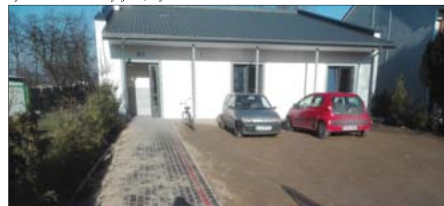
Odbudowa Domu Ludowego w Krężnicy Okrągłej, wartość inwestycji to 20 tys. zł., które pokrył w całości fundusz sołecki.
