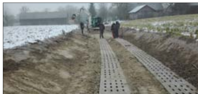
Przebudowa drogi gminnej w m. Skrzyniec Kolonia. Działka Nr 394. Wartość inwestycji 10 tys. zł. Odcinek 60 mb.
