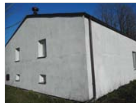
Modernizacja Domu Ludowego w miejscowości Chmielnik. Wartość zadania 12,3 tys. zł. Sfinansowano z funduszu sołeckiego.
