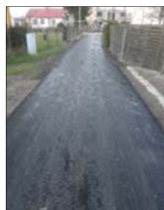
Przebudowa ul. Sadowej – Nr 107034L. Wartość zadania 19,8 tys. zł. Odcinek 56 m.
