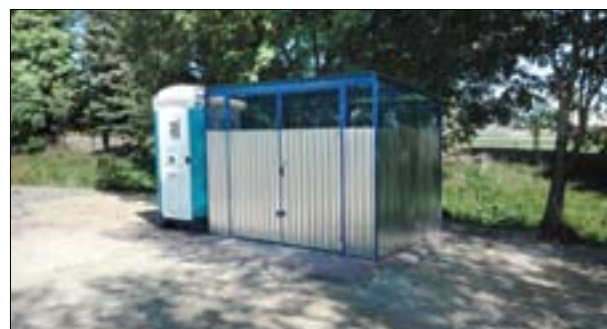
Zakup i montaż wiaty śmietnikowej na placu targowym przy ul. Szpitalnej. Wartość 3,5 tys. zł.
