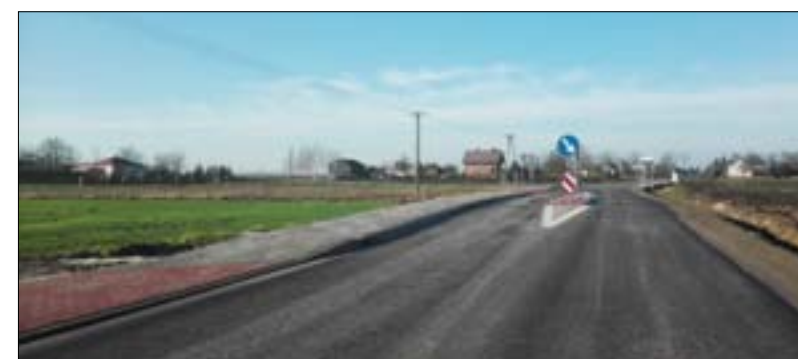
Przebudowa ciągu komunikacyjnego obejmującego drogi powiatowe Nr 2238L, 2239L, 2240L na terenie gminy Bełżyce. Wartość zadania 10275 tys. zł. Więcej o tej inwestycji piszemy na str.11.
