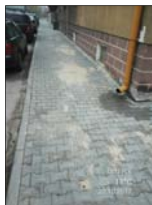
Przebudowa chodnika przy ul. Bednarskiej. Wartość inwestycji 19 tys. zł. Powierzchnia 180 m2.
