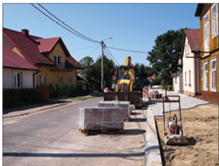
Od kilku tygodni na ulicy Tysiąclecia trwa wymiana chodników. Projekt przewiduje ponadto poprawę nawierzchni drogowej. Jest to w kolejności druga ulica po Prebendarzkiej, która zostanie zmodernizowana w ramach jednego projektu. Po zakończeniu remontu w tym miejscu ruszą prace na ulicy Nachmana.
