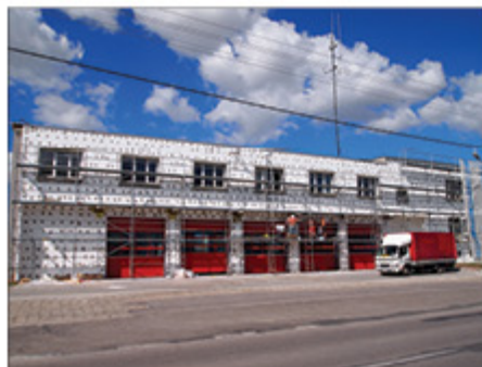
Trwa remont strażnicy PSP w Bełżycach. Budynek został poddany termomodernizacji oraz wymieniono bramy garażowe.
