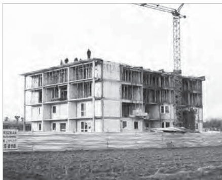
Zaawansowane prace przy budowie bloku przy ulicy Wojska Polskiego
