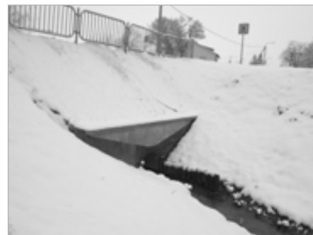
Wyremontowany przepust wodny na Krężniczance.
