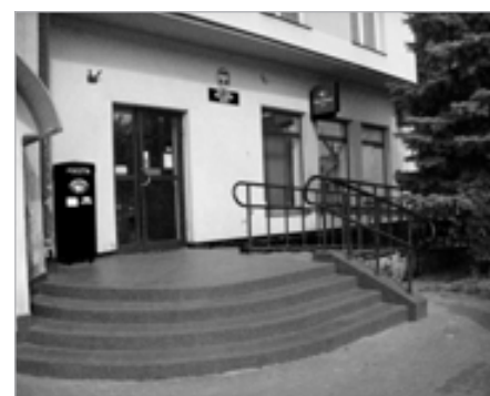
Wymiana płytek na schodach przed wejściem do Urzędu Poczтового poprawiła bezpieczeństwo klientów korzystających z usług
