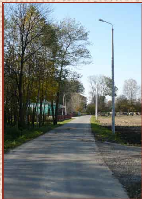
Oświetlenie i droga w m. Wymysłówka
