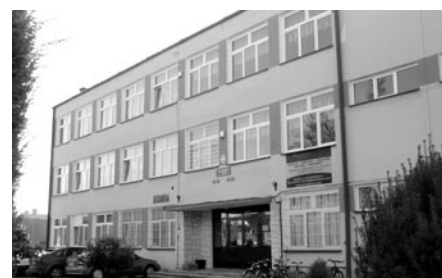
Wymiana stolarki okiennej w ZS Nr 1 w Bełżycach
