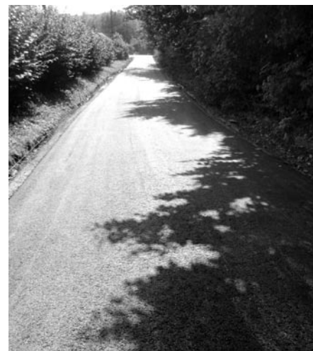
Przebudowa drogi w m. Wierzchowiska Stare – w trakcie realizacji
