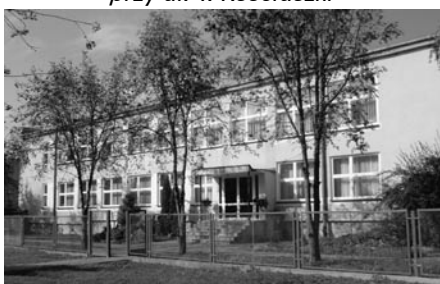
Wymiana stolarki okiennej w Samorządowym Przedszkolu Publicznym
