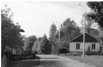
Budowa oświetlenia drogowego w m. Wierzchowiska Stare
