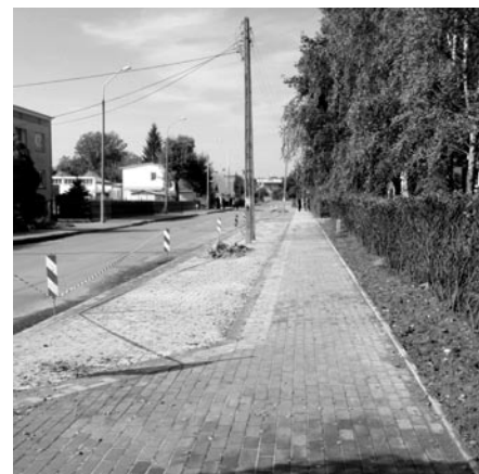
Remont chodnika przy ul. Wilczyńskiego, budowa zatok
